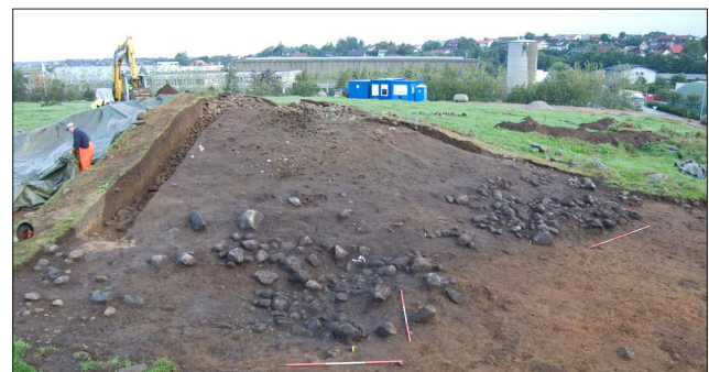
Fig. 102. Anlegg 11546 i forgrunnen med E23 og E24 til høyre. Fig. 102. Feature 11546 in the foreground with contexts E23 and E24 to the right.
